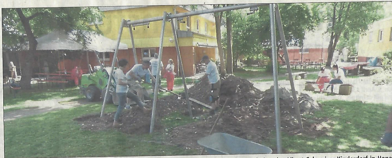
Fast 100 Mitarbeiter der DB Netz AG haben als Helfer für Aufbau- und Renovierungsarbeiten im Albert-Schweizer-Kinderdorf in Hanau tüchtig angepackt. ■ Foto: p
