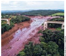
Die Schlammmassen haben diese Eisenbahnbrücke zerstört
